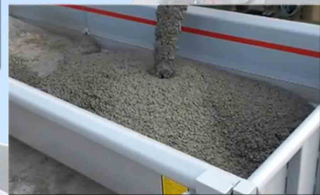
1 Le caisson reçoit les retours de béton.
