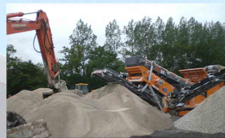
4 Le bloc est transformé en matériaux de terrassement.
